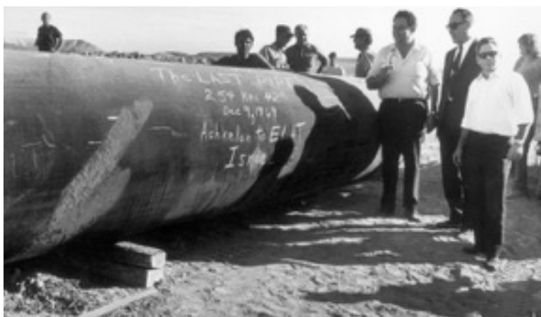
Установка последней секции трубопровода Ашкелон-Эйлат, 1969. © Daniel Rosenblum / Starfot
