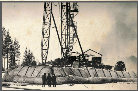
Буровая на воздушной подушке. Разработка Главтюменьнефтегаза.
