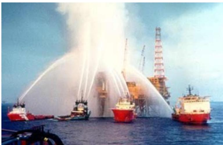
Если первый выброс платформа пережила, то второй, 24 апреля 1988 года, её добил. Это произошло в тот момент, когда платформу пытались переориентировать с нефти на газ. Произошел выброс, превентор не сработал, и потоком газа трубы вышибло из скважины, как
