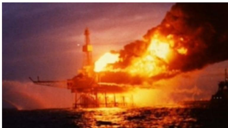
Платформа была не новая, 1976 года выпуска, переоборудованная из нефтедобывающей в газодобывающую, что важно для понимания проблемы. На платформе было установлено два насоса, качающих газоконденсат на берег. Утром один из них был остановлен на плановую
